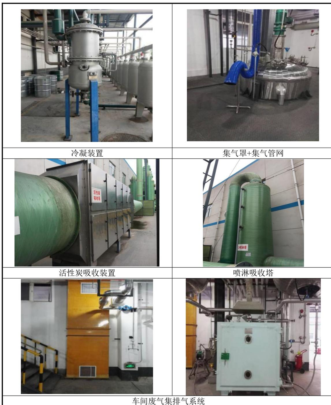
图 7.1-2 现有工程的废气污染防治设施图
