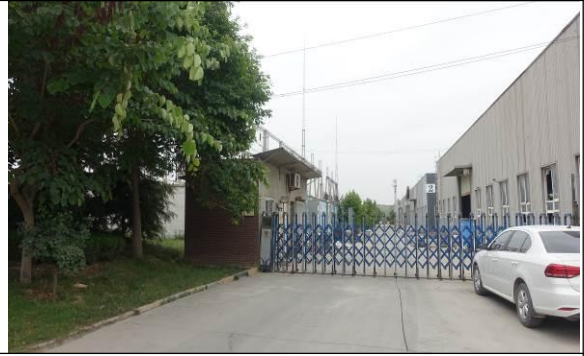
长春110kV变电站东侧110kV电缆进线处
