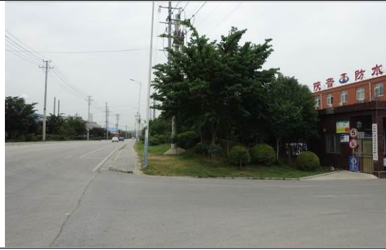
工业大道地下电缆段
