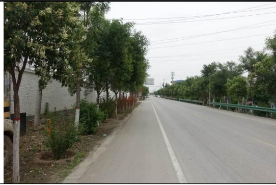
架空线路跨越庄里变南侧公路
