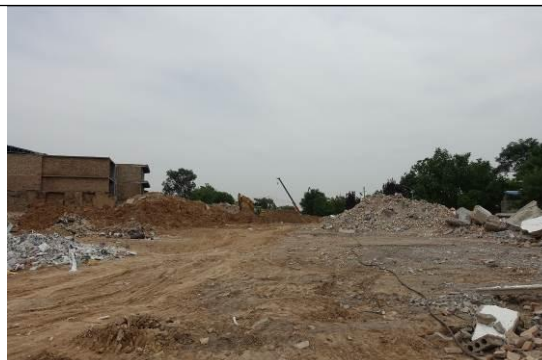
地下电缆与建设中的西延高铁平行敷设段 (现状调查时元陵堡村部分民房正在拆除)
