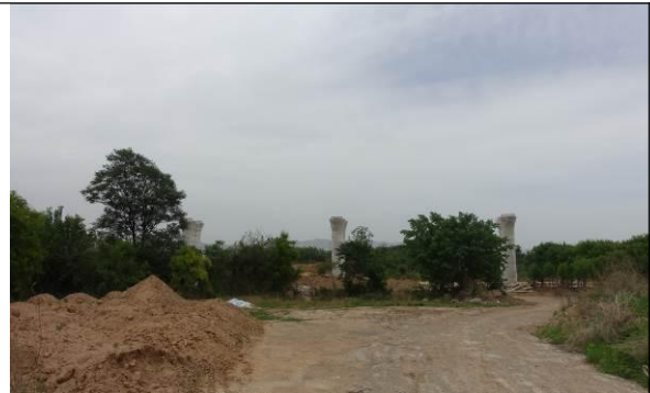
至建设中的西延高铁架空线路改落地电缆处
