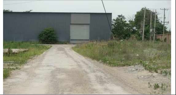
西吕村东侧某厂房
