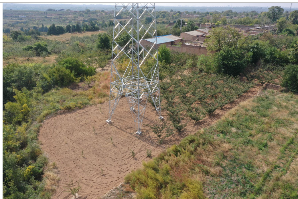
G13（拆除后重建）塔基土地利用现状
